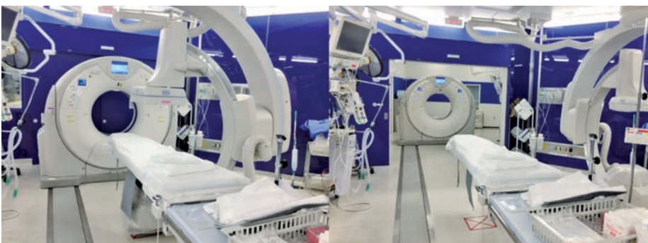
図1 2ルーム型HERS (済生会横浜市東部病院) HERSで救急診療が行われていない間は、CTガントリを隣室へ移動させて従来型CTとして運用することで、IVR-CTを有効活用する。
